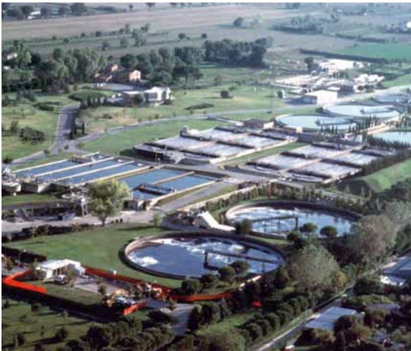
Prato, impianto di depurazione acque Gida
